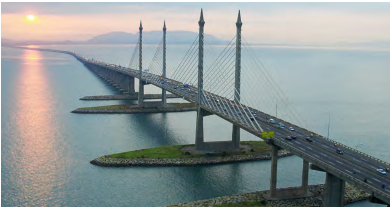
Pemandangan matahari terbit di Jambatan Pulau Pinang.
