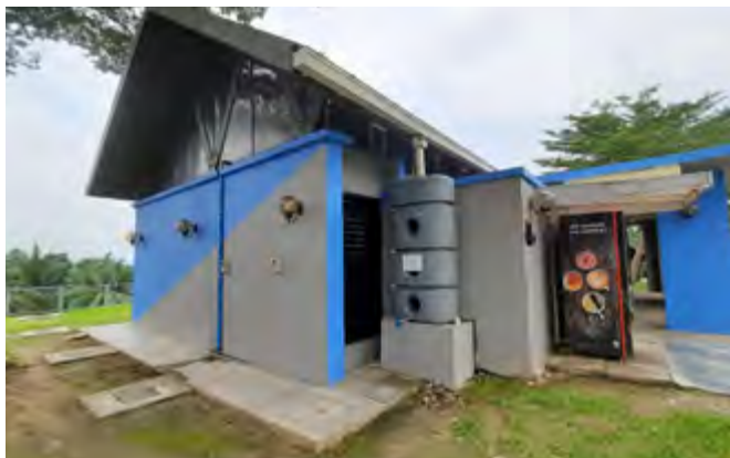
Sistem penuaian air hujan di Hentian Sebelah Yong Peng.
