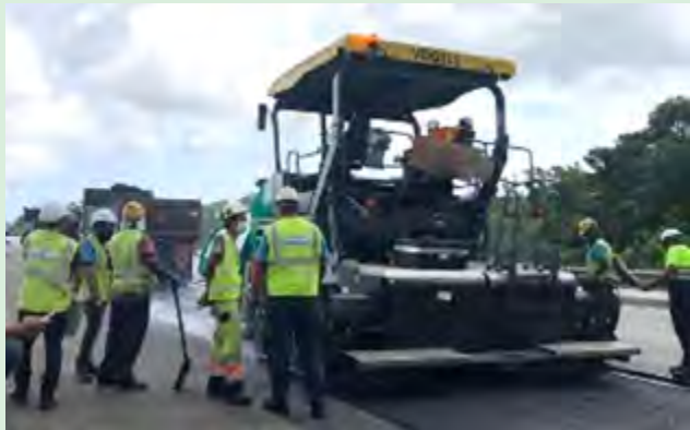
Lokasi percubaan untuk asfalt kitar semula HIP di Seksyen C3.
