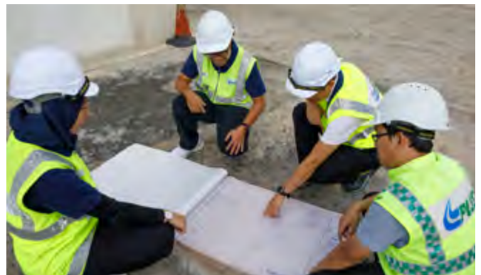
Jurutera kami memakai PPE yang sewajarnya ketika melakukan penyelenggaraan bangunan pejabat kami.
