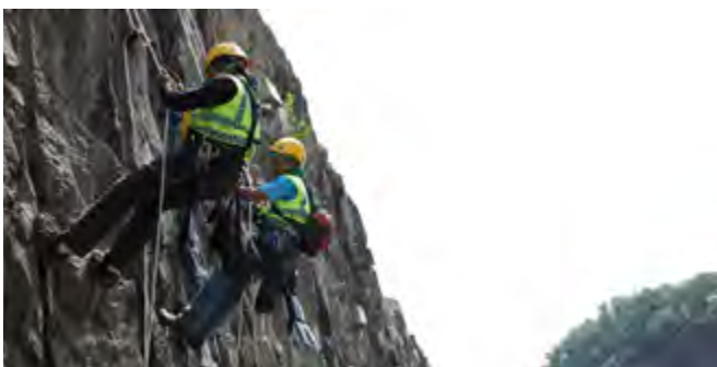
Pasukan penyelenggaraan kami melakukan pemeriksaan cerun untuk memastikan keselamatan pelanggan lebuh raya.
